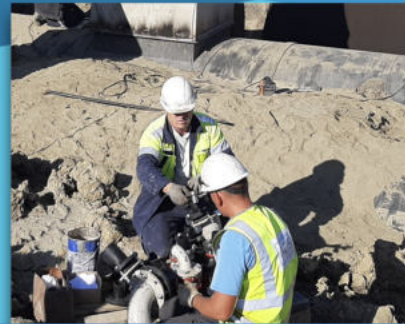
Реконструкция и строительство АЗС
